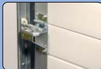
Uchwyt rolki na aluminiowym wykończeniu segmentu
